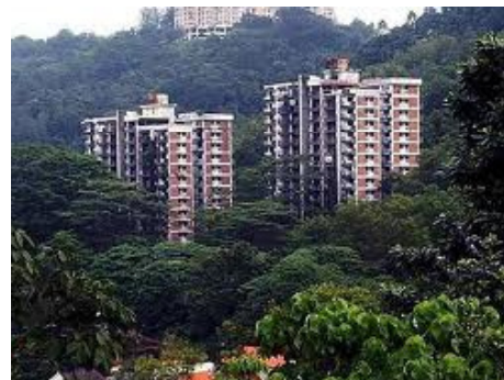
Pembinaan bangunan di atas tanah tinggi
