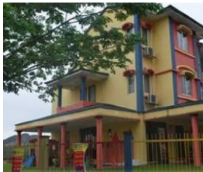
Penukaran penggunaan bangunan kediaman kepada tadika
