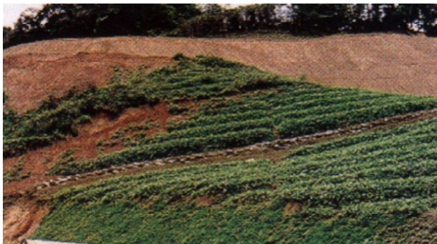
Pembangunan di atas bukit
