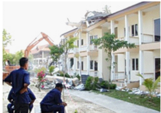
Pemantauan kerja perobohan bangunan oleh penguatkuasa
