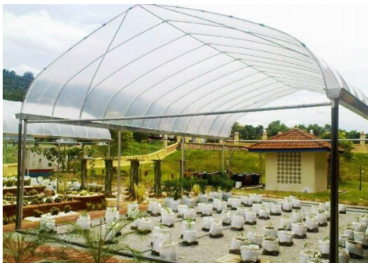
Foto 2: Contoh teknologi struktur pelindung hujan dan sistem pengairan renjis ( sprinkler ) Sumber: RTD Segamat 2030(Penggantian)
