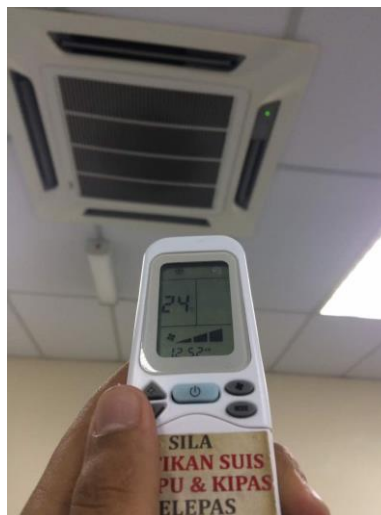
Foto 28: Mengawal tahap keselesaan suhu ruang daripada penyaman udara dengan menetakannya pada 24°C Sumber: PIMRK KL 2030
