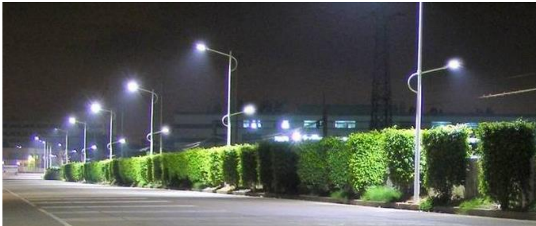
Foto 10: Pemasangan lampu jalan jenis LED
